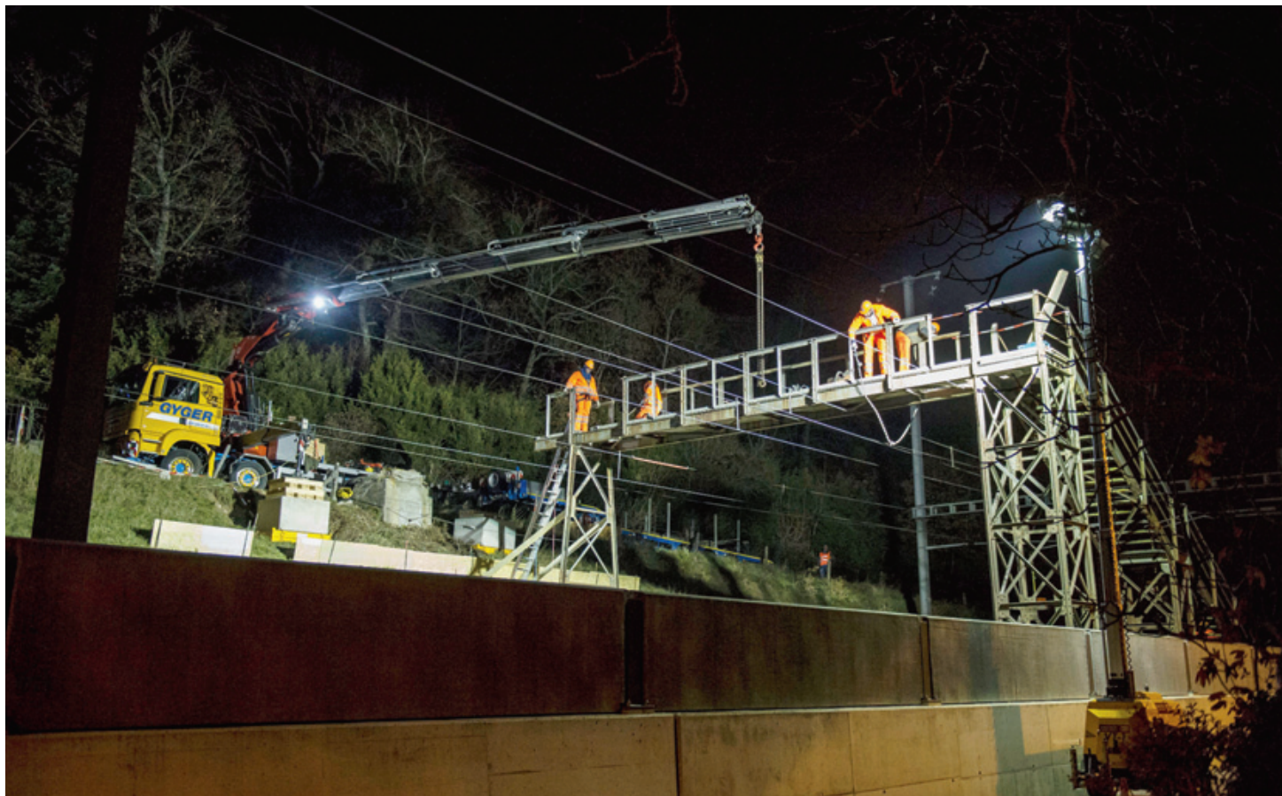
La passerelle doit être soutenue par la grue avant que les ouvriers ne scient ses extrémités pour la détacher. LUCAS VUITEL
